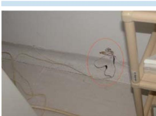
**Figura 4.** No conformidad en la inspección de la unidad de mamografía. Conexiones eléctricas inadecuadas (visita inicial).
